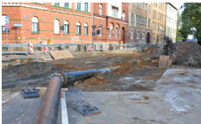
Zwischen Großer Deichstraße und Leopold-Kell-Straße sind noch Restarbeiten zu erledigen.
