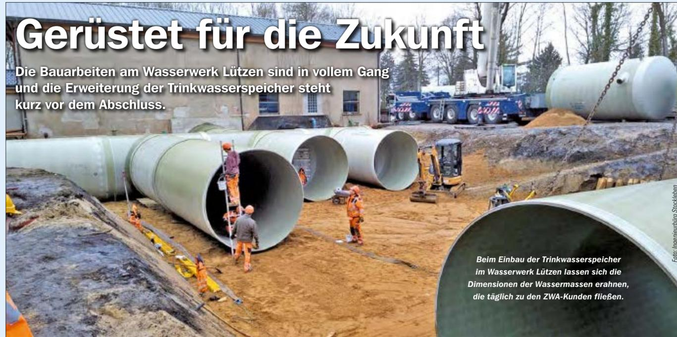
Beim Einbau der Trinkwasserspeicher im Wasserwerk Lützen lassen sich die Dimensionen der Wassermassen erahnen, die täglich zu den ZWA-Kunden fließen.
