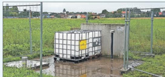
Unscheinbar, aber effektiv: In diesen Behältern am Pumpwerk Friedensdorf wurden die Klärwerksschlämme gelagert und in regelmäßigen Abständen in den Abwasserstrom der Druckleitung zur Kläranlage gepumpt.
