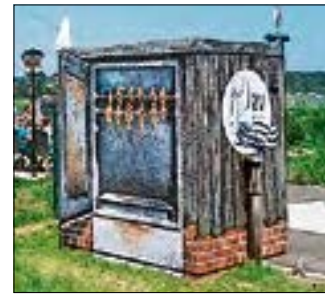
Hmmm, da kommt Appetit auf frisch geräucherten Fisch auf, wenn man die Pumpstation des Zweckverbandes Wolgast-Festland betrachtet.
