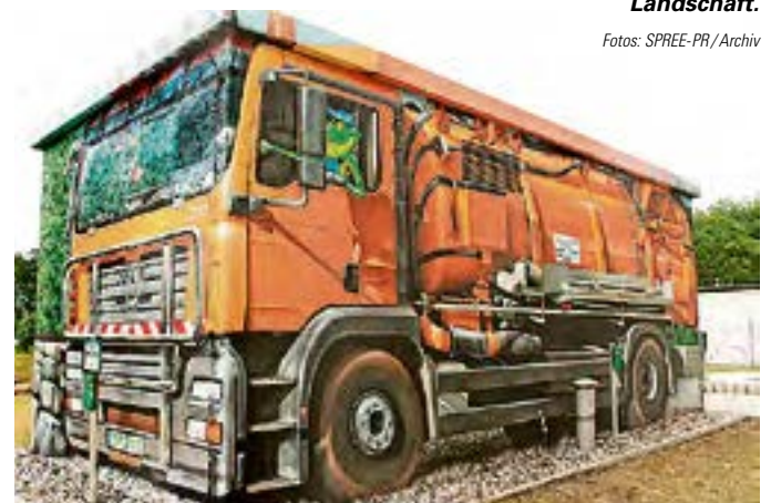
Dies ist kein Pumpfahrzeug!!! Der Künstler hat jeden Quadratzentimeter der Pumpstation für sein Gemälde genutzt.
