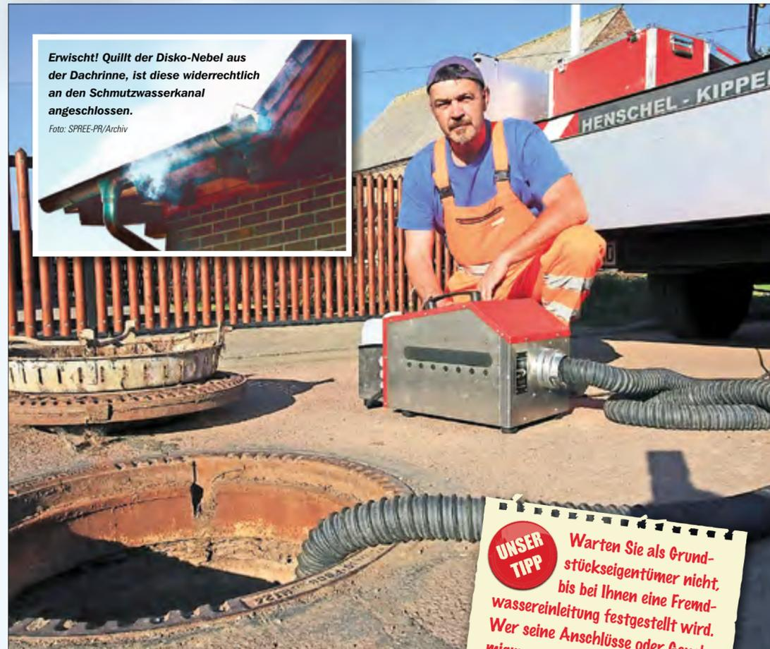
Erwischt! Quillt der Disko-Nebel aus der Dachrinne, ist diese widerrechtlich an den Schmutzwasserkanal angeschlossen.
