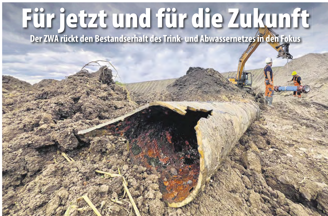
Versorgungssicherheit: Im Juli 2025 gab es umfangreiche Baumaßnahmen am Trinkwassernetz nahe Friedensdorf. In Folge eines Bauprojektes der Deutschen Bahn kam es zu einer Havarie. Über 60 Jahre alte Leitungen wurden daraufhin vom ZWA erneuert.
