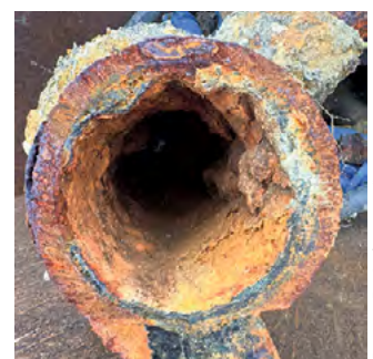
Veraltete Leitungen zwingen Verbände zu teuren Erneuerungen.
